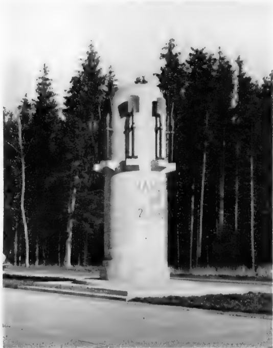
Monument commémorant la construction de la première autostrade de Munich à Salzbourg, terminée le 21 mars 1934.
